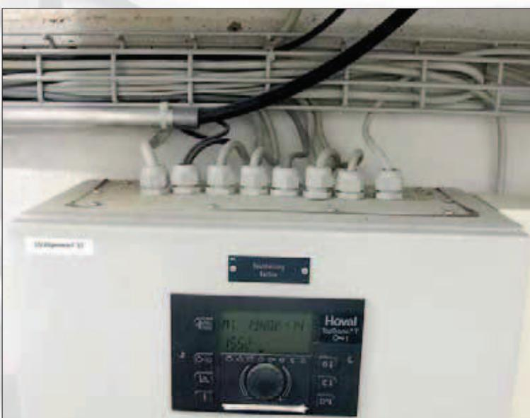
Mit Kabelverschraubungen schützen Sie sensible Bauteile im Anlage- und Apparatebau vor Staub, Schmutz und Nässe
