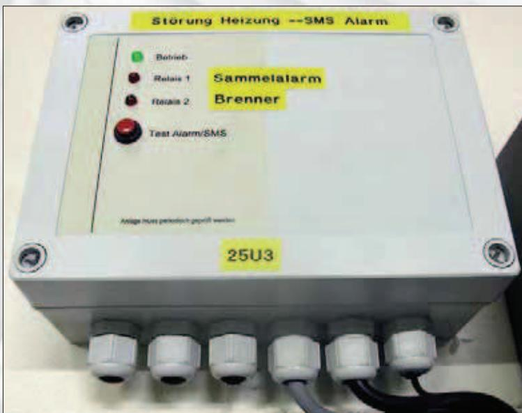
Auch Steuerungsanlagen sind mit Plica-Kabelverschraubungen eine «dichte Sache»
