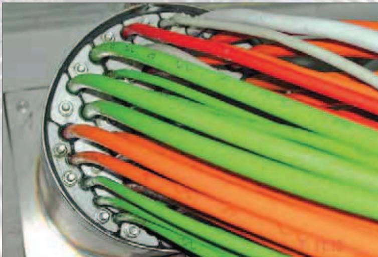
Oft sind auf Baustellen pragmatische Lösungen erforderlich, um Kabel- und Rohrleitungen gas- und wasser-tight durchzuführen. Wo Standardlösungen nicht mehr genügen, kann Plica in aller Regel passende Sonderbauteile liefern
